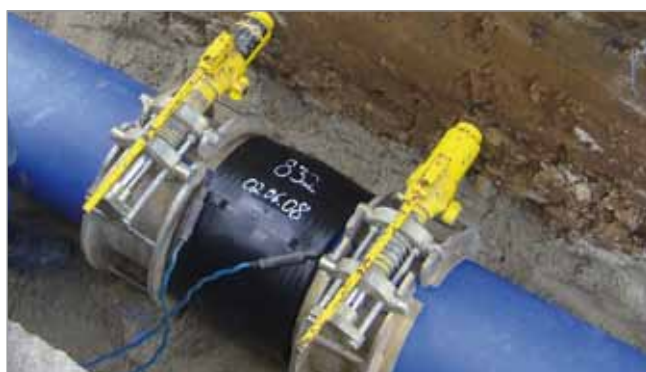
Obr. : Zakružovací svěrky pro elektrotvarovku (Zdroj: +GF+)
